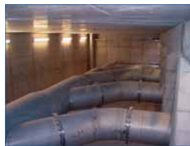
Рис. 4.1.1.2c: Врезка отдельных напорных трубопроводов в коллектор по потоку
