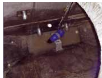
Рис. 5.7: Мешалка с погружным двигателем в зумпфе
